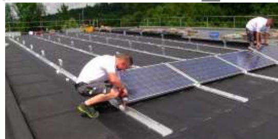
Umístění fotovoltaických panelů na ploché střeše
