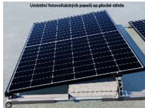
Umístění fotovoltaických panelů na ploché střeše
