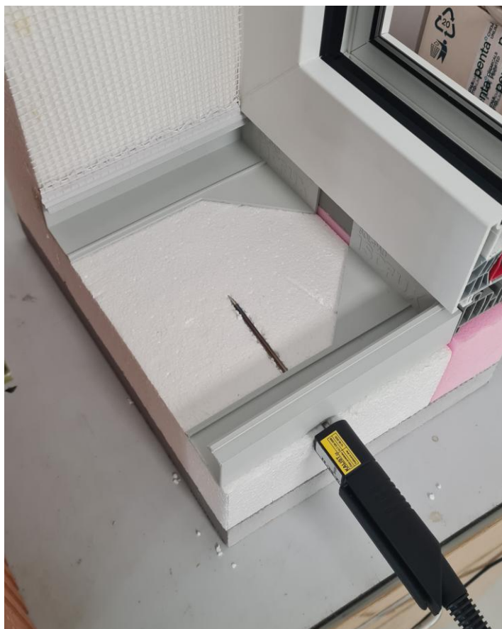
Tepelná sonda pod parapetem
