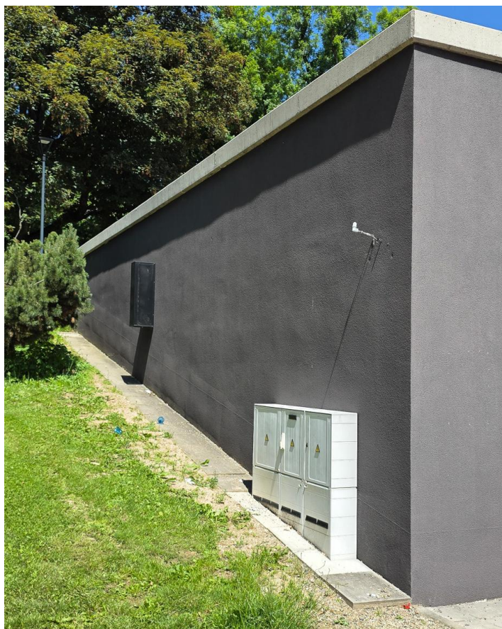
Tmavý odstín fasády
