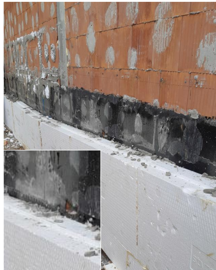
Kotvení lišty přes hydroizolaci
