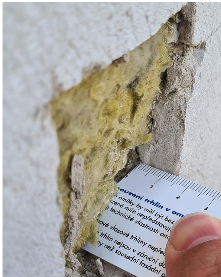
Velká vrstvy stěrky
