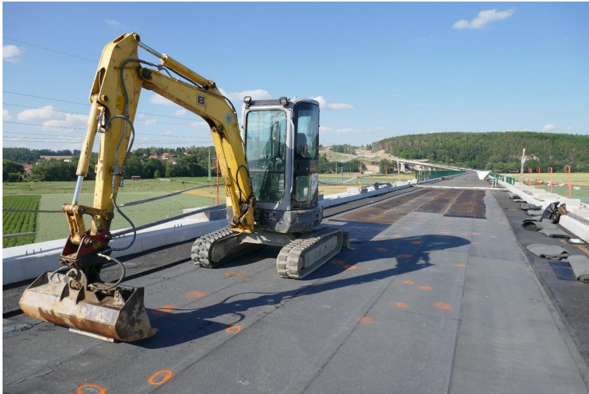
Obr. č. 21 Porucha na mostě. Odstraňování hydroizolační vrstvy. Zdroj: Vlastní.
