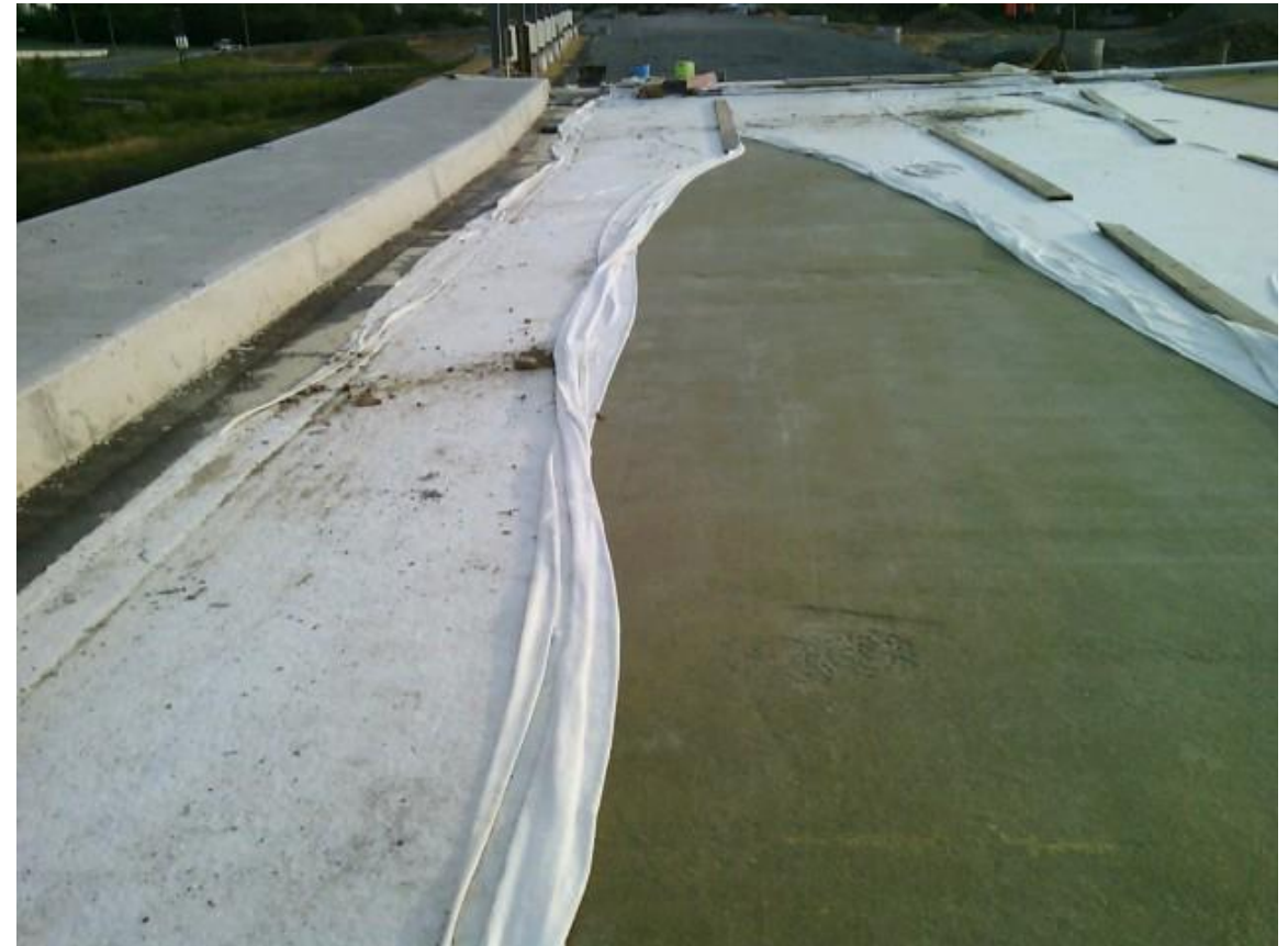
Obr. č. 19 Porucha na mostě. Boule na hydroizolační vrstvě. Zdroj: vlastní.
