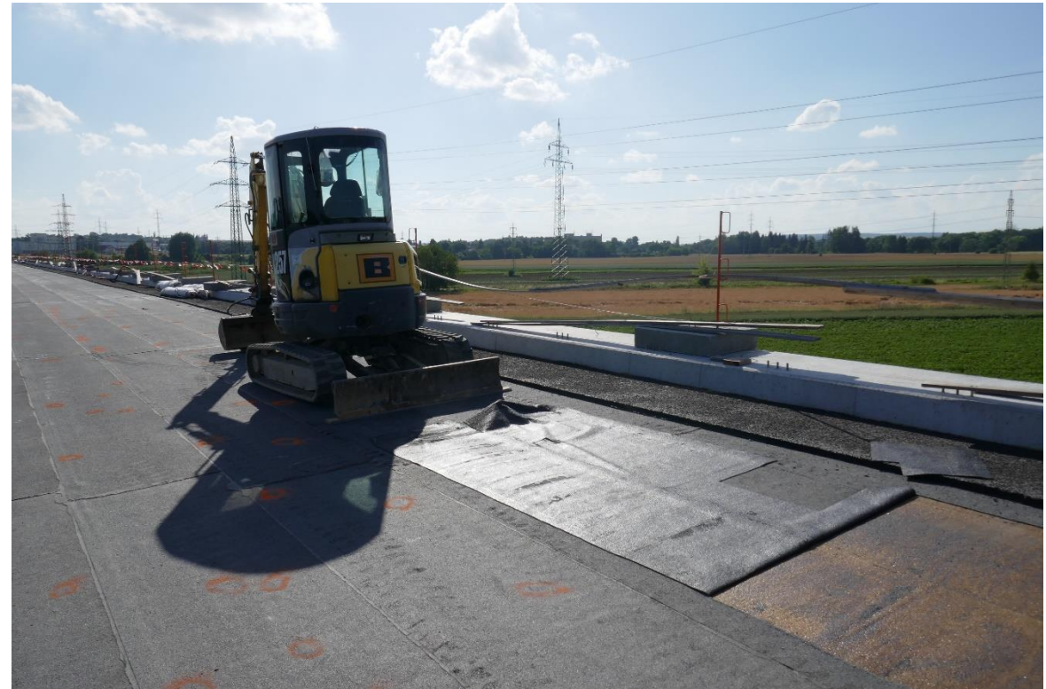
Obr. č. 21 Porucha na mostě. Odstraňování hydroizolační vrstvy. Zdroj: Vlastní.
