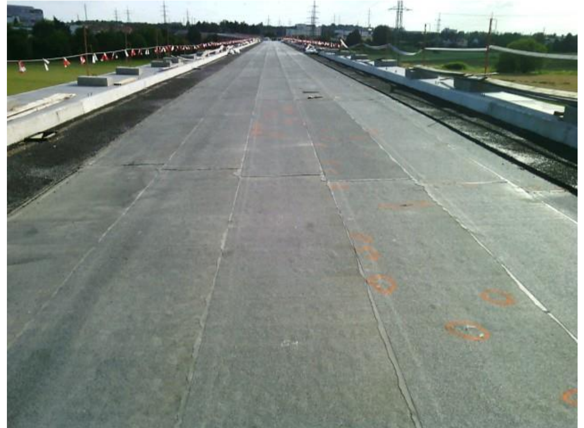
Obr. 17. Porucha na mostě. Boule na hydroizolační vrstvě. Zdroj: vlastní.
