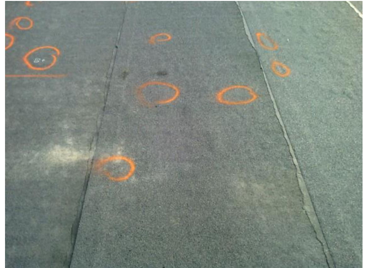
Obr. č.18 Porucha na mostě. Boule na hydroizolační vrstvě. Zdroj: vlastní.
