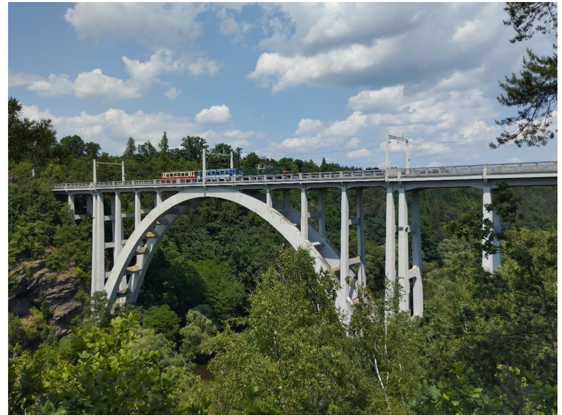
Obr. č.2 Bechyňská duha, žb. most s horní mostovkou. Zdroj: Vlastní
