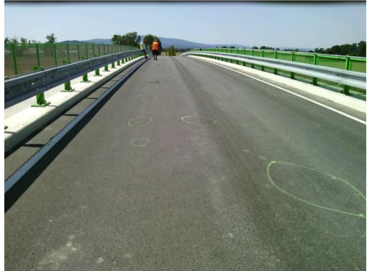
Obr. č. 20 Porucha na mostě. Boule na obrušné vrstvě. Zdroj: Vlastní.
