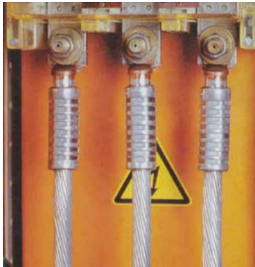
Správné připojení hliníkového vodiče k měděné přípojnici, zdroj: ELEKTRO 11/2009
