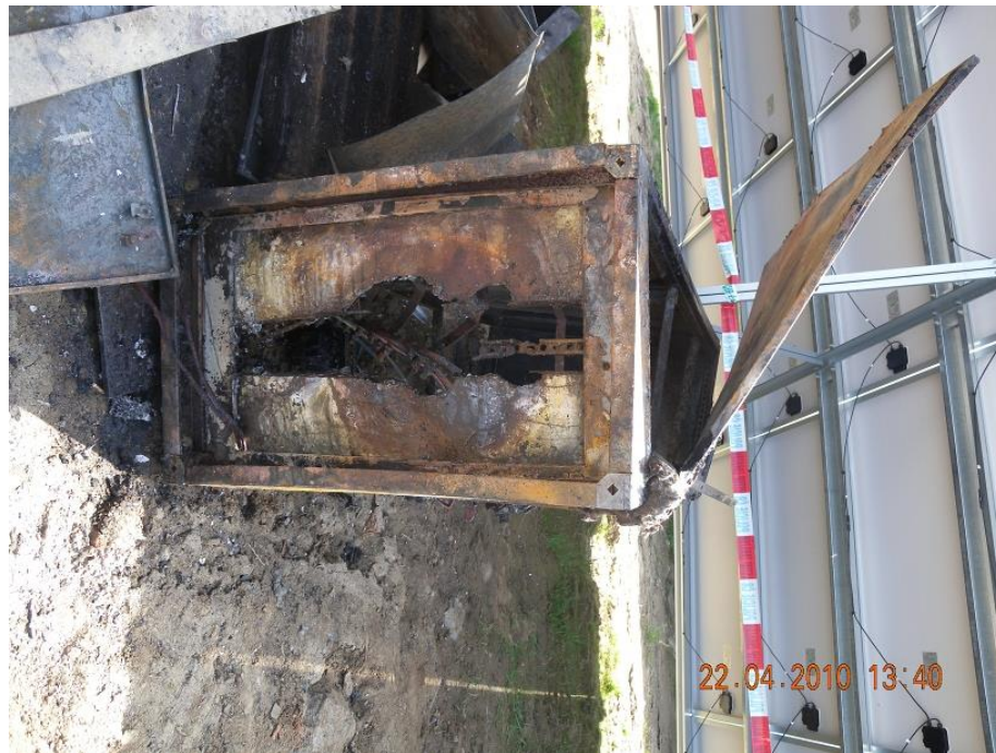
Zkratové účinky kabelového vedení na spodní část skříně sběrnice
