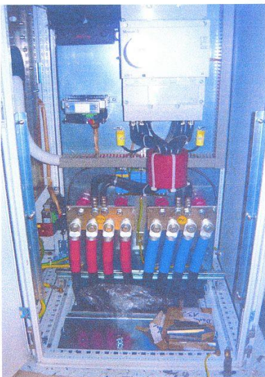
Původní stav sběrnice DC části
