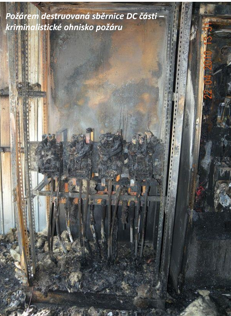
Zkratové účinky kabelového vedení na spodní část skříně sběrnice
