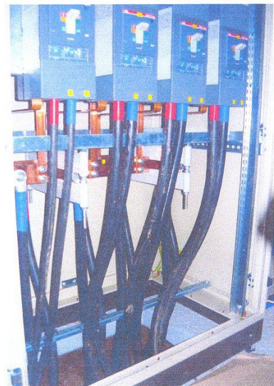
Původní stav sběrnice DC části
