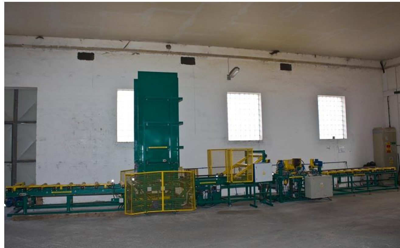
Pohled na stavební provedení konstrukcí
