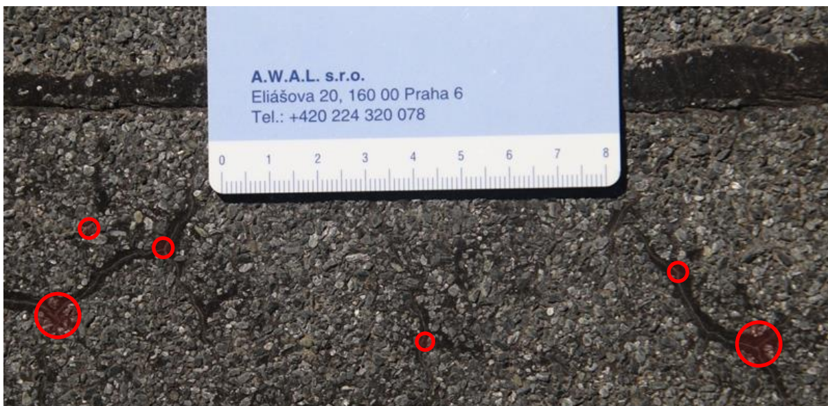
Obr. č. 12 – Detail krokodýligu s identifikací jeho velikosti – vložené kruhy jsou velikosti 10, resp. 5 mm
